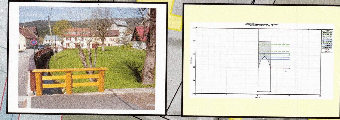
Le Meaudret : pont au niveau du restaurant "Le chalet Suisse"
